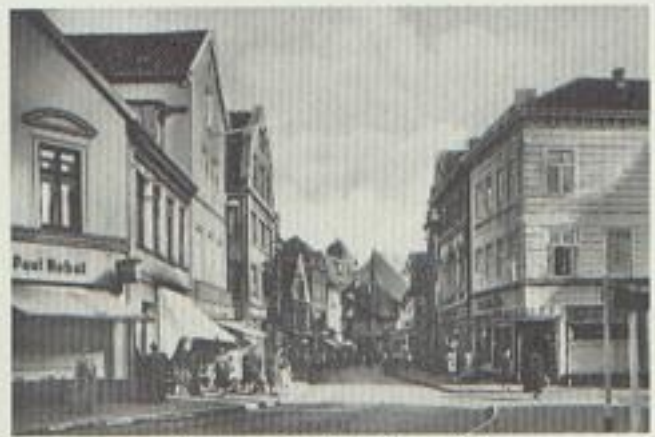
Blick in die Großstraße um 1940
